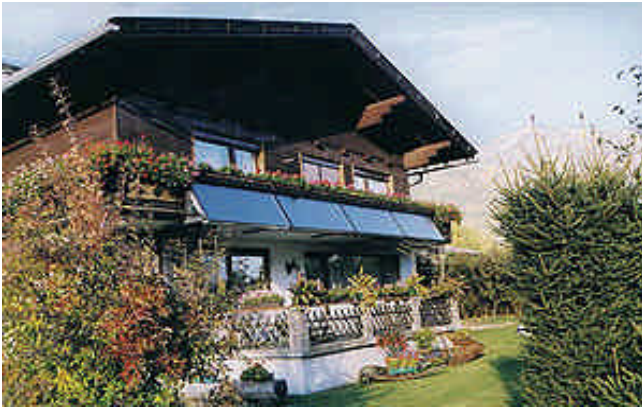
Impianto solare combinato per una casa unifamiliare in Austria. Superficie collettori 8 m 2
