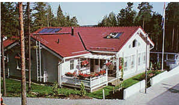
Impianto solare combinato per una casa unifamiliare in Finlandia. Superficie collettori 7,5 m 2
