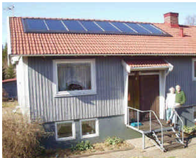
Impianto solare combinato per una casa unifamiliare in Svezia. Superficie collettori: 12,4 m 2
