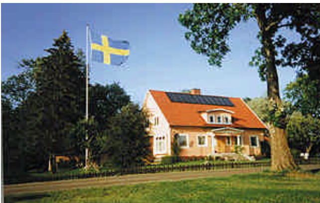
Impianto solare combinato per una casa unifamiliare in Svezia. Superficie collettori: 18,5 m 2
