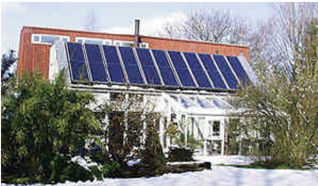
Impianto solare combinato per una casa unifamiliare in Danimarca. Superficie collettori: 26 m 2
