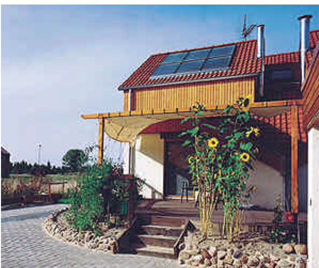
Impianto solare combinato per una casa unifamiliare in Germania. Superficie collettori: 7,5 m 2
