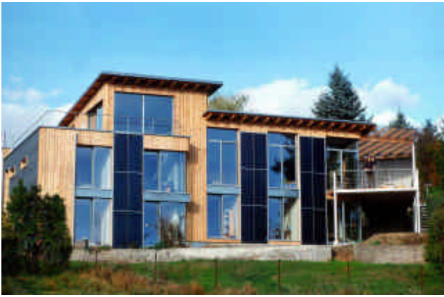
Impianto solare combinato per una casa unifamiliare in Austria. Superficie collettori: 36 m 2
