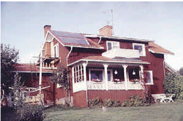
Impianto solare combinato per una casa unifamiliare in Svezia. Superficie collettori: 10 m 2
