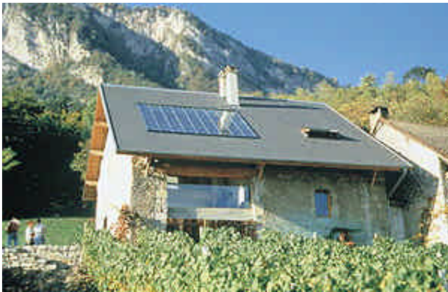
Impianto solare combinato per una casa unifamiliare in Savoia/Francia. Superficie collettori 15 m 2
