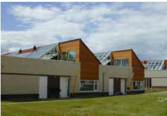
Impianto solare combinato per una casa a schiera in Olanda. Superficie collettori 4,1 m²
