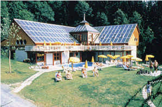
Impianto solare combinato con riscaldamento piscina per un albergo in Carinzia/Austria. Superficie collettori: 144 m 2
