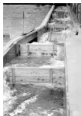
Scale di risalita per pesci, inserita nell'alveo per consentire la risalita dell'ostacolo rappresentato dalla traversa
